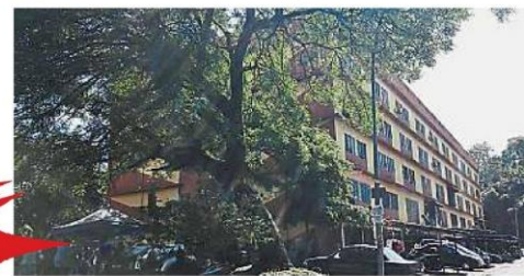
沙再也花园B座组屋3楼的电房早前发生爆炸后,导致组屋3楼断电断水。
